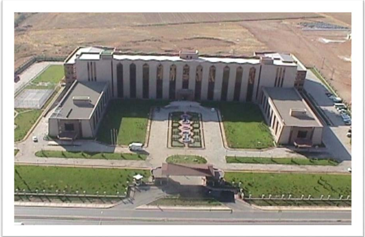
Resim 2- Başkanlık Hizmet Binası (Üstten Görünüm)
